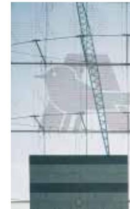
Durchdach: Auf den Obergurten der Windträger sind Waagbalken aus Flacheisen aufgeschweißt, an deren Ende die RODAN Glasklemmhalter befestigt sind.
